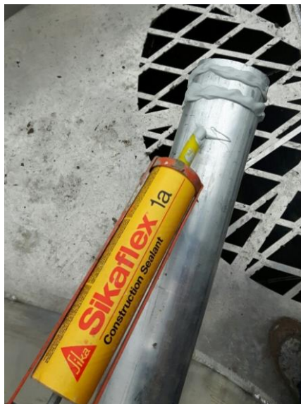
FIGURE 8 : JOINT D'ÉTANCHÉITÉ SUR LE TUYAU D'HUILE
